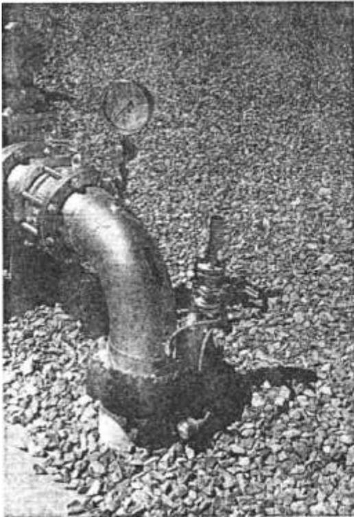
Fig. 6.44. Protección contra sobretensiones para bridas de aislamiento, por medio de una vía de chispas de separación, protegida contra explosiones.
