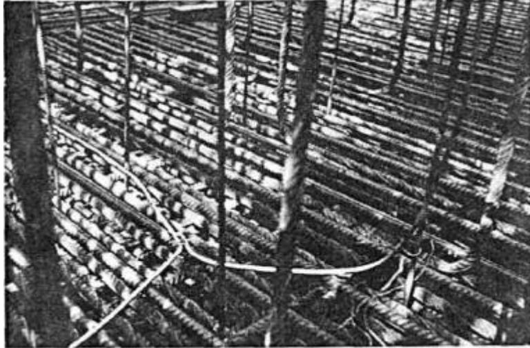
Fig. 6.24. El armado de los cimientos se incluye en la instalación de toma de tierra.
