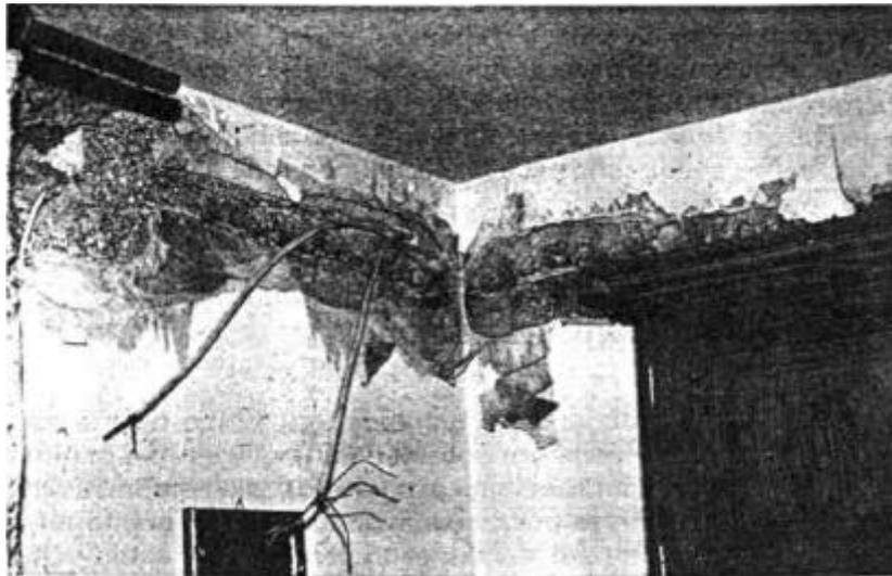
Fig. 2.1. Daños causados por sobretensiones de rayo en instalaciones de consumidores de baja tensión.
