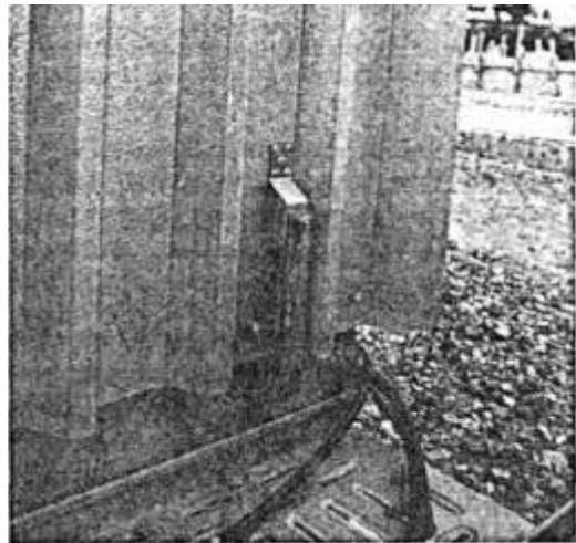
Fig. 6.28. Revestimiento metálico de chapa, en una nave de fabricación, para blindaje, provisto de su correspondiente banderola de toma de tierra.
