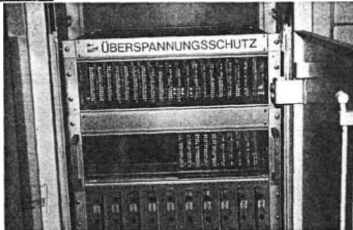
Fig. 6.63. b) Salidas protegidas de los conductores (hacia la central).
