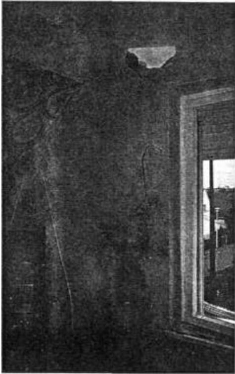
A causa de la proyección de piezas de una caja de distribución de la habitación, incandescentes, sobre una de las camas, ésta se incendió (Figura 2.26). A lo largo del cable de la antena fluyeron corrientes parciales de rayo, quedando aquella desprendida de la pared, y el televisor conectado al cable de antena, quedó igual destruido (Figura 2.27).
